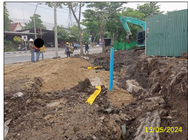
ค) กิจกรรมการวางแถบสีเหลือง (Warning Tape)
