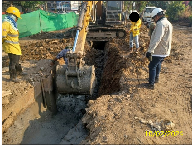
บริเวณ SECTION 1 : HDD 4.1 ก) กิจกรรมการขุดเปิด
