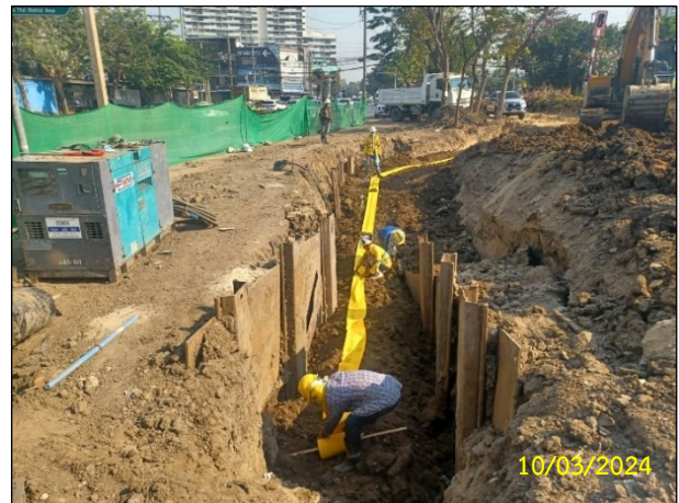
บริเวณ SECTION 1 : HDD 4.1 ง) กิจกรรมการวางแถบสีเหลือง (Warning Tape)
