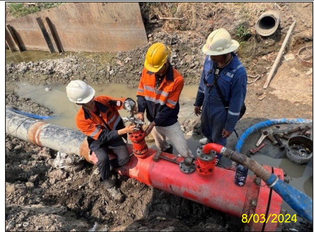
บริเวณ SECTION 1 : Open Cut 4.1 ข) กิจกรรมการทดสอบท่อด้วยวิธีทางชลสถิต (Hydrostatic Test)
