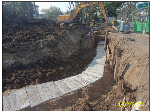
บริเวณ SECTION 1 : HDD 4.1 ง) กิจกรรมการวางแผ่นคอนกรีต (Concrete Slab)
