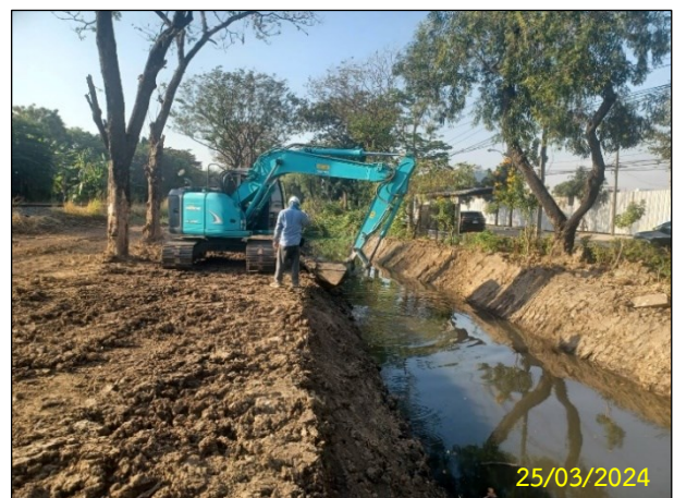
บริเวณ SECTION 1 : Open Cut 4.1 ฉ) กิจกรรมการคืนสภาพพื้นที่ (Re-instatement)
