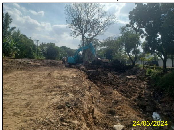
บริเวณ SECTION 1 : Open Cut 4.1 จ) กิจกรรมการกลบท่อ (Backfilling)
