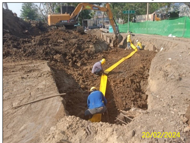
บริเวณ SECTION 1 : HDD 4.1 จ) กิจกรรมการวางแถบสีเหลือง (Warning Tape)
