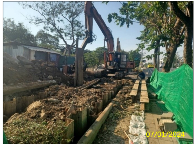
บริเวณ SECTION 1 : HDD 4 ข) กิจกรรมการติดตั้ง Sheet Pile
