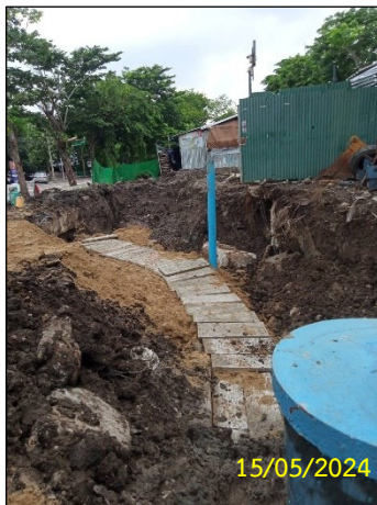
ข) กิจกรรมการวางแผ่นคอนกรีต (Concrete Slab)
