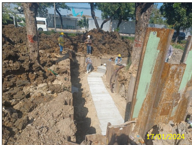
บริเวณ SECTION 1 : HDD 3 จ) กิจกรรมการวางแผ่นคอนกรีต (Concrete Slab)
