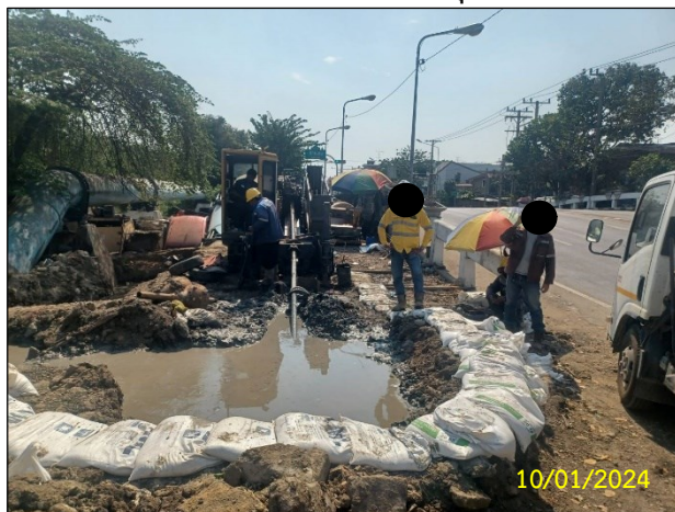
บริเวณ SECTION 1: HDD 4 ค) กิจกรรมการเจาะลอด (HDD)
