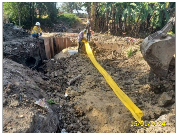
บริเวณ SECTION 1 : HDD 3 ง) กิจกรรมการวางแถบสีเหลือง (Warning Tape)
