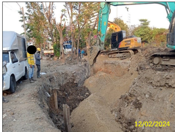
บริเวณ SECTION 1 : HDD 4.1 ค) กิจกรรมการกลบท่อ (Backfilling)
