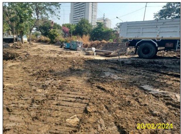
บริเวณ SECTION 1 : HDD 4.1 ฉ) กิจกรรมการคืนสภาพพื้นที่ (Re-instatement)
