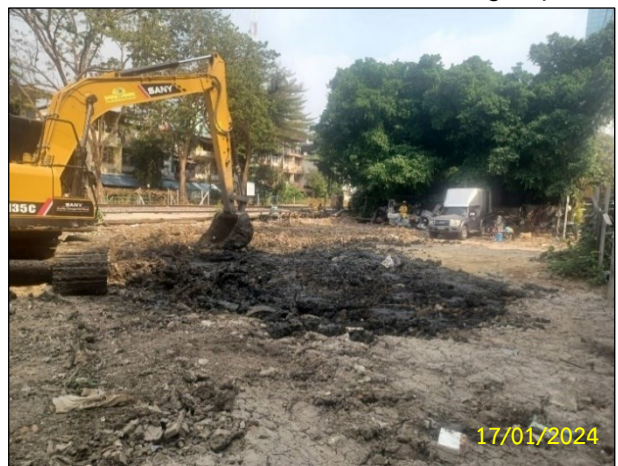
บริเวณ SECTION 1 : HDD 3 ฉ) กิจกรรมการกลับท่อ (Backfilling)
